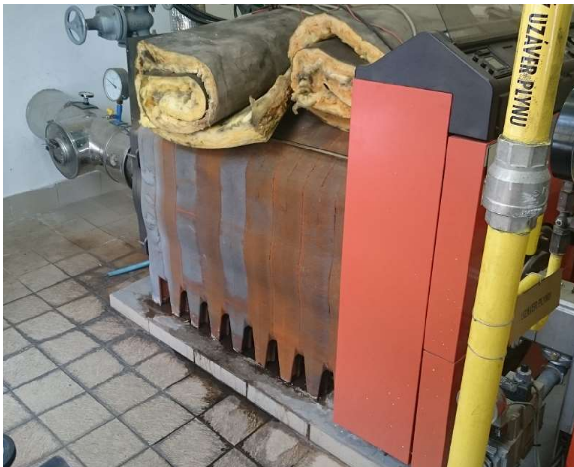
Obr.2 – Usporiadanie článkov, pretekanie vody z kotlového bloku
