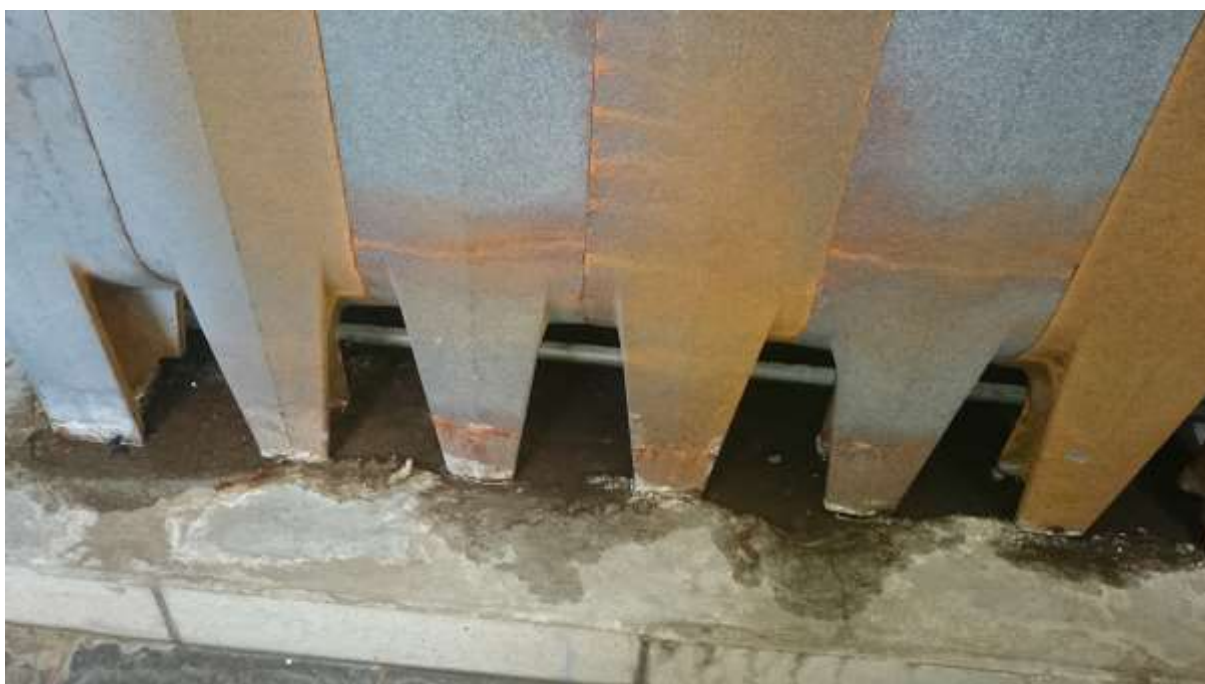
Obr.2 – Usporiadanie článkov, pretekanie vody z kotlového bloku
